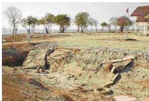
マングローブのなかった タイ・ラノー県近郊タレノーク。 被害が生じました。
