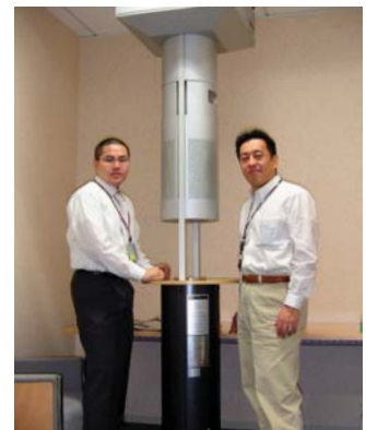
分煙室内の吸煙装置
