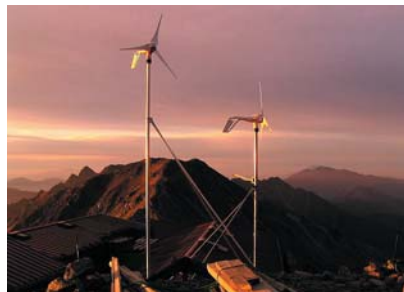
投資先の風力発電装置
