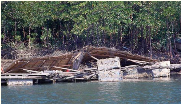
ラノーンのマングローブ植林地区。津波により、漁船をつなぐ栈橋と小屋は押し流されたが、マングローブ後方の土地は守られた。(写真上、下)
