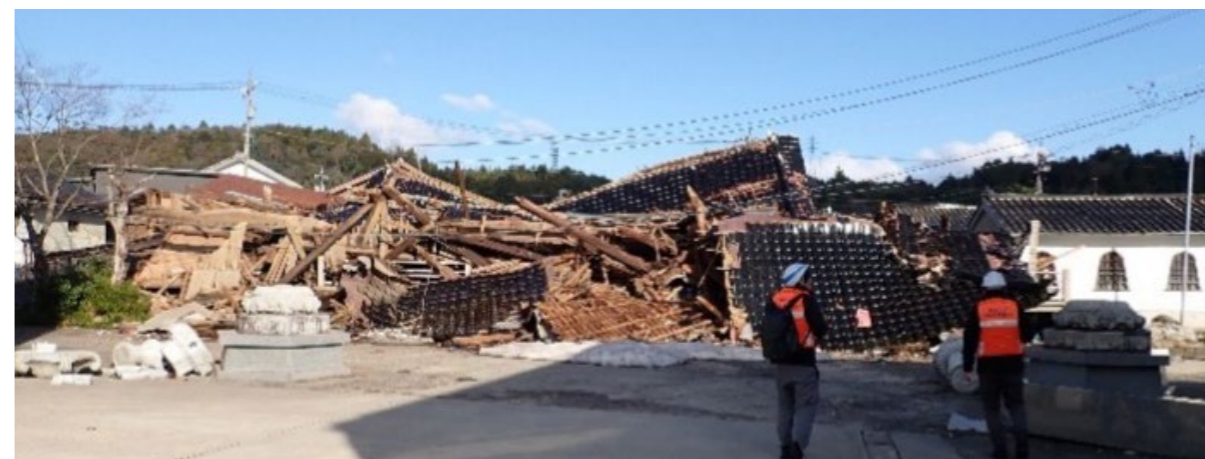
図1 2016年熊本地震の建物被害
