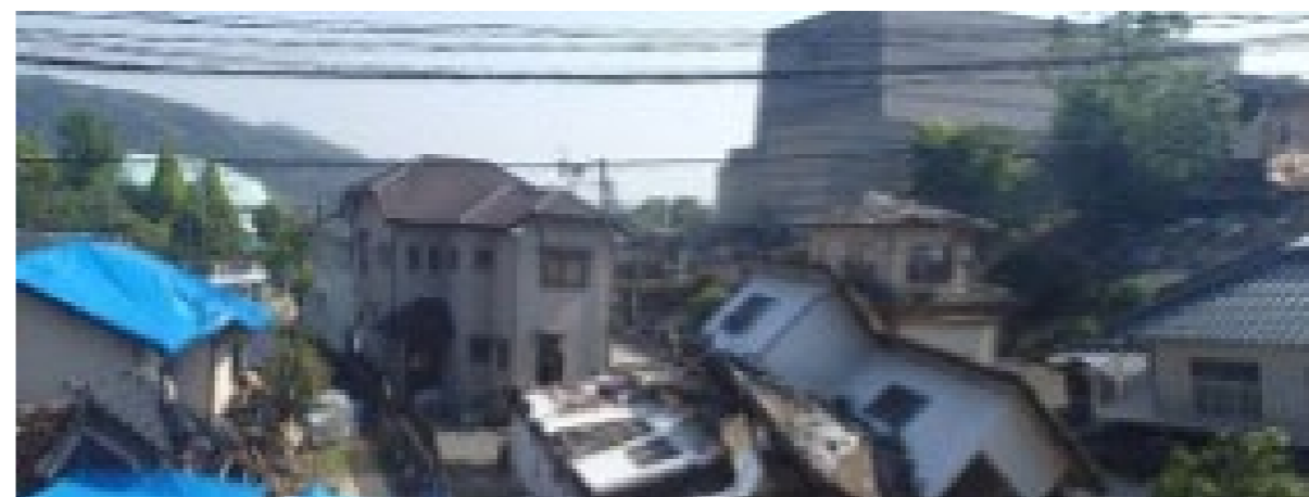
図2 2024年能登半島の建物被害
