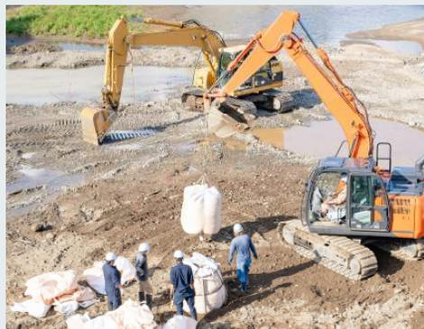
地震後に、液状化しにくい地盤にするための改良工事
