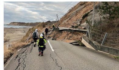
令和6年能登半島地震での発災直後の国道調査の様子
