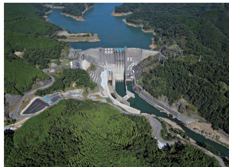
下流から見た再開発事業完了後の鶴田ダム(2018年)※3
