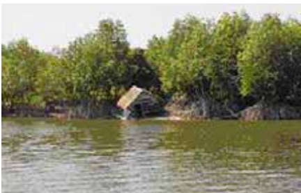
タイ・ラノーン県のマングローブ植林地区。マングローブ後方の土地は津波被害から守られました
