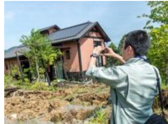
現場での損害確認
